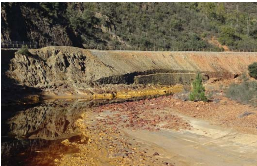
Blick von der Brücke über den Río Tinto auf die alte Eisenbahntrasse westlich des Flusses, über die seit 2019 der Camino Polivalente bzw. die Via Verde del Río Tinto bis zur Station Los Frailes führt
